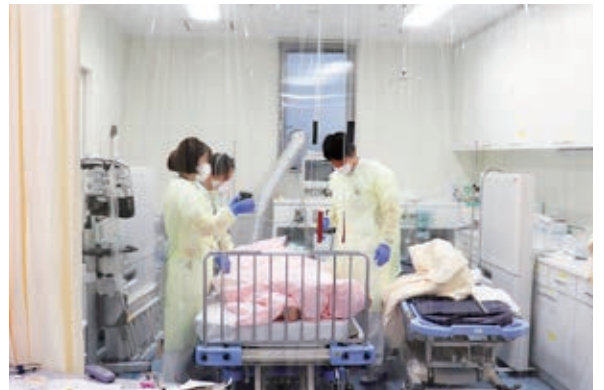
各床の様子。ビニールカーテンで仕切り、ベッドの両側にヘパフィルター設置、換気用ダクトホースを窓に伸ばし空気を排出。
