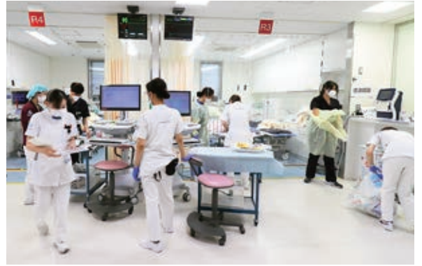
オープンスペースの重症ベッド2床(R3,4)に仮設式の陰圧装置を整備。(下↓は各床の拡大写真)
