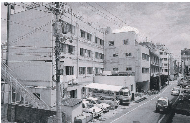
▲サーモコンの1病棟の西側に接して建設された7病棟。写真は取り壊し直前の写真。ここは現在の近森リハビリテーション病院の場所にあたる（『医療法人近森会50周年記念誌歴史篇』から）
