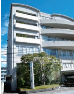
近森オルソリハビリテーション病院 (上)と一階ホール付近より
