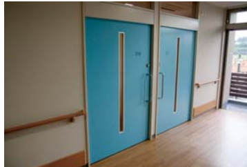
▲全室個室が売り！ 階ごとに扉を色分けしている
