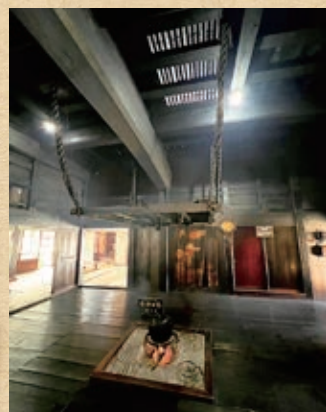
▲ 神田家の1階 囲炉裏部屋。2階以上では養蚕が行われ、囲炉裏の煙はすのこ状の天井を通り抜け、蚕の飼育に適した温度を保ち、茅や木材を虫や腐食から守っていた。
